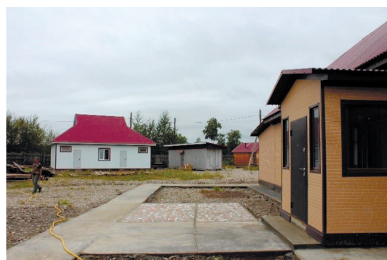
Ведутся работы по строительству пекарни и магазина на Дальневосточном гектаре
