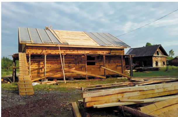
Строительство ИЖС Алексева М.С. на Дальневосточном гектаре, с. Арка
